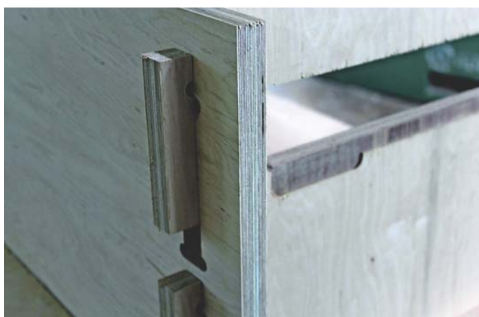
/ Klassische Prinzipien modern umgesetzt: Präzise, digital hergestellte Holzverbindungen machen die Transportwagen stabil und gleichzeitig zerlegbar.
